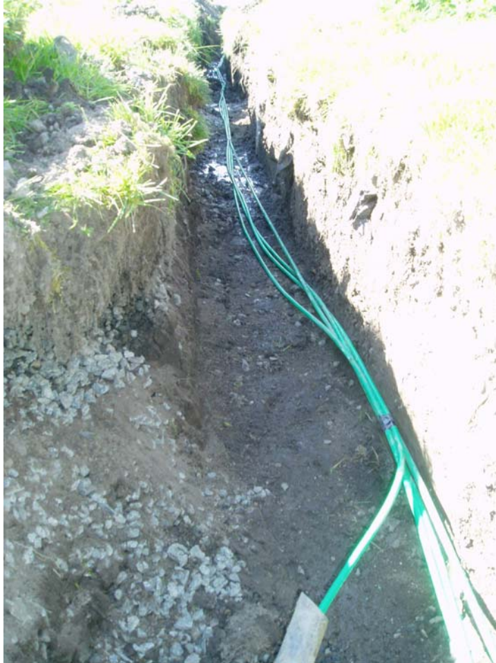
Bild 81. Schakt över 4:7 mot 4:7 b
