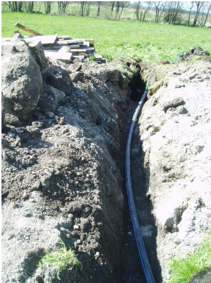
Bild 85. Schakt över 4:7 skydds slang i vägpassage
