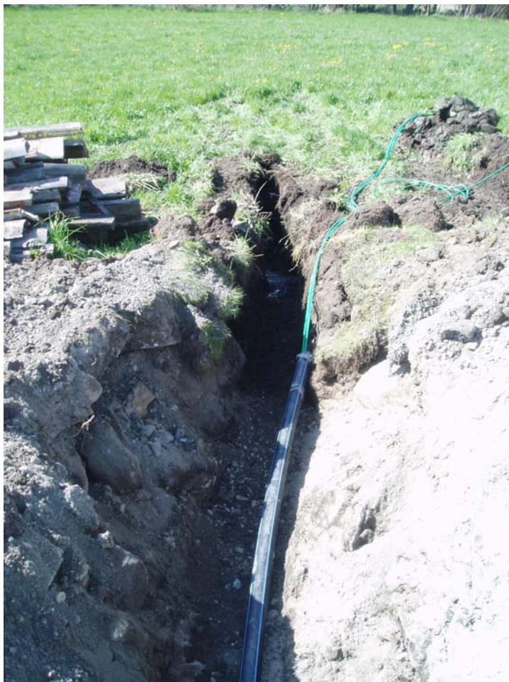
Bild 86. Schakt över 4:7 skydds slang i vägpassage
