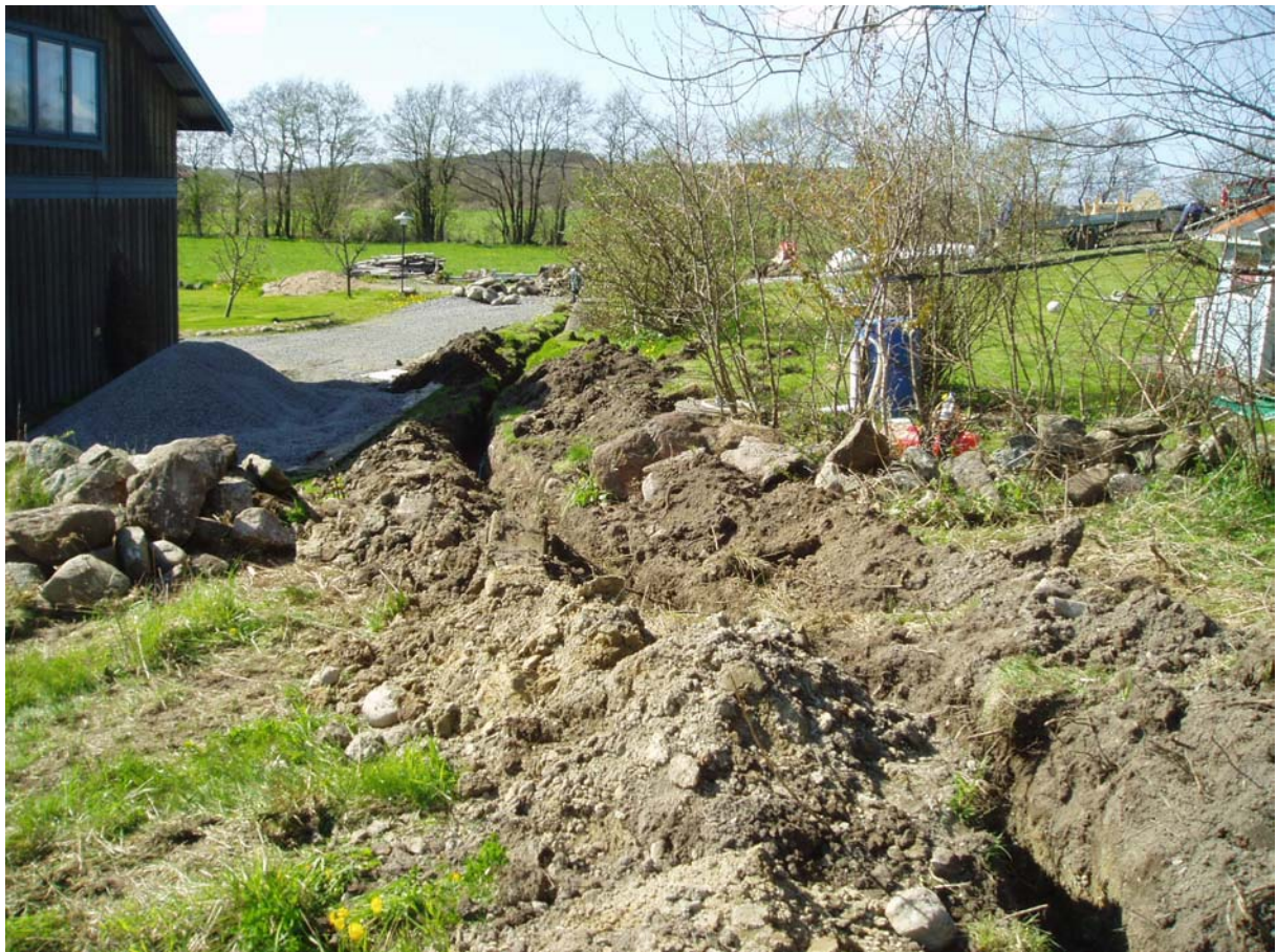
Bild 96. Schakt över 4:7 och mot 5:8
