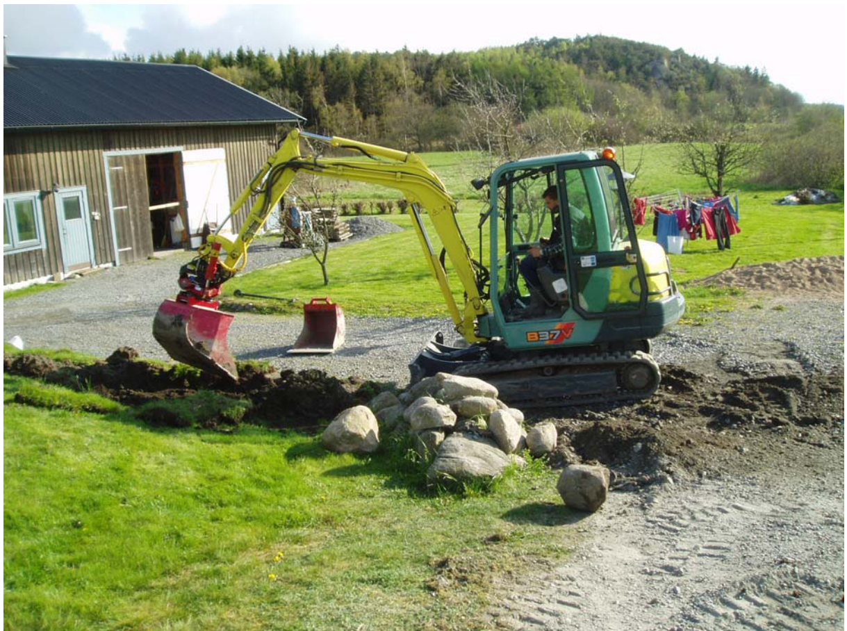
Bild 98. Återfyllnad schakt 4:7
