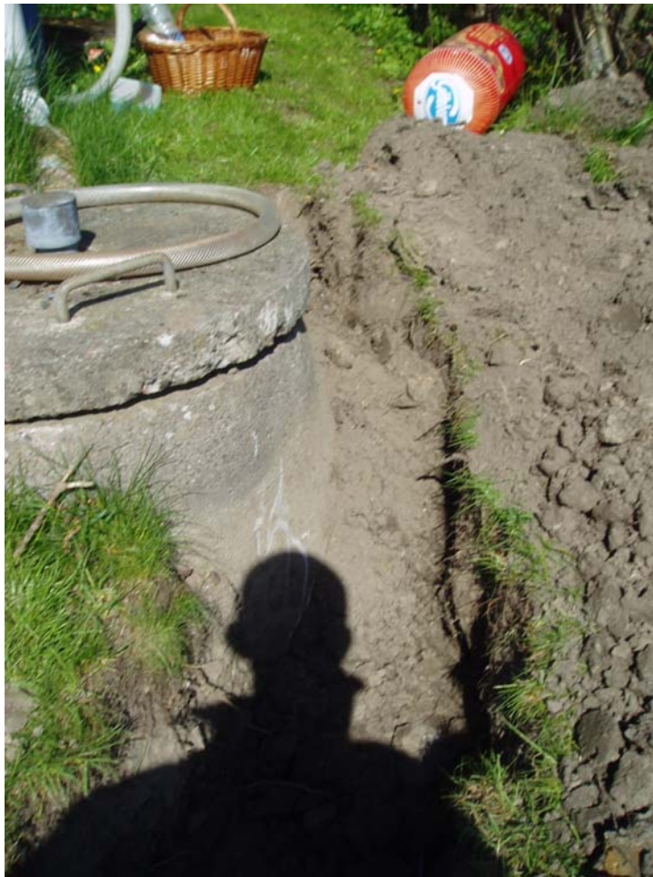
Bild 95. Schakt mot 4:7 a
