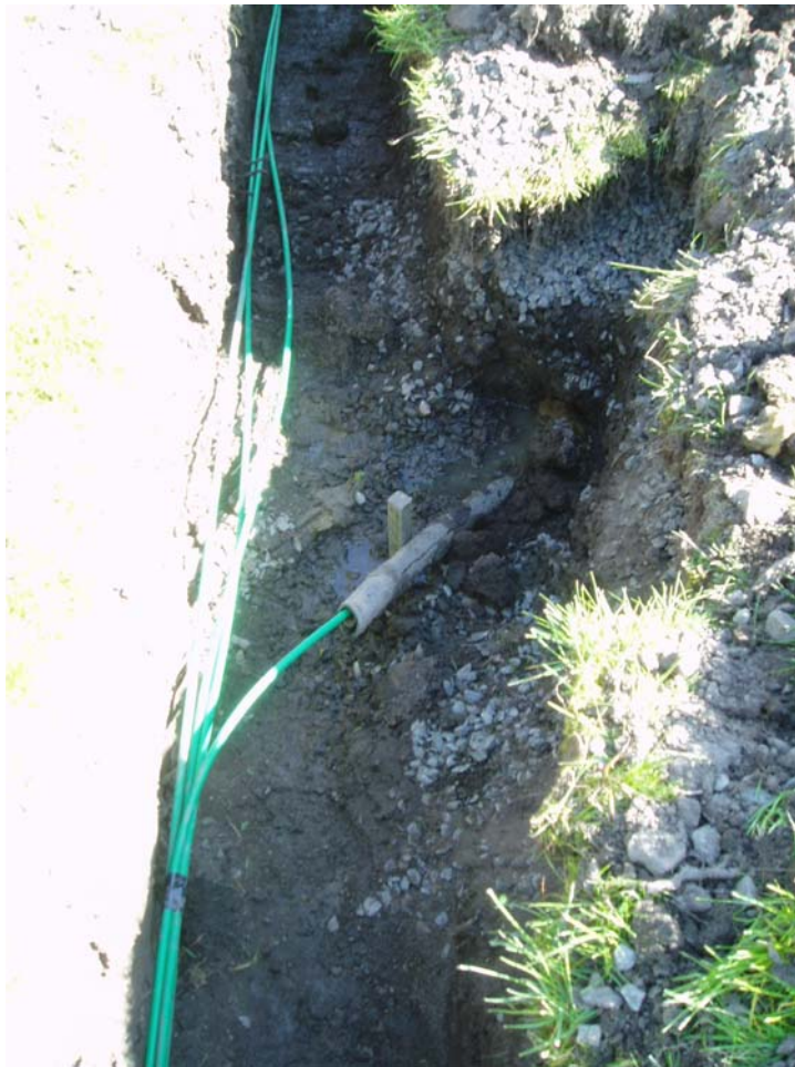
Bild 93. Schakt över 4:7 mot 4:7 b
